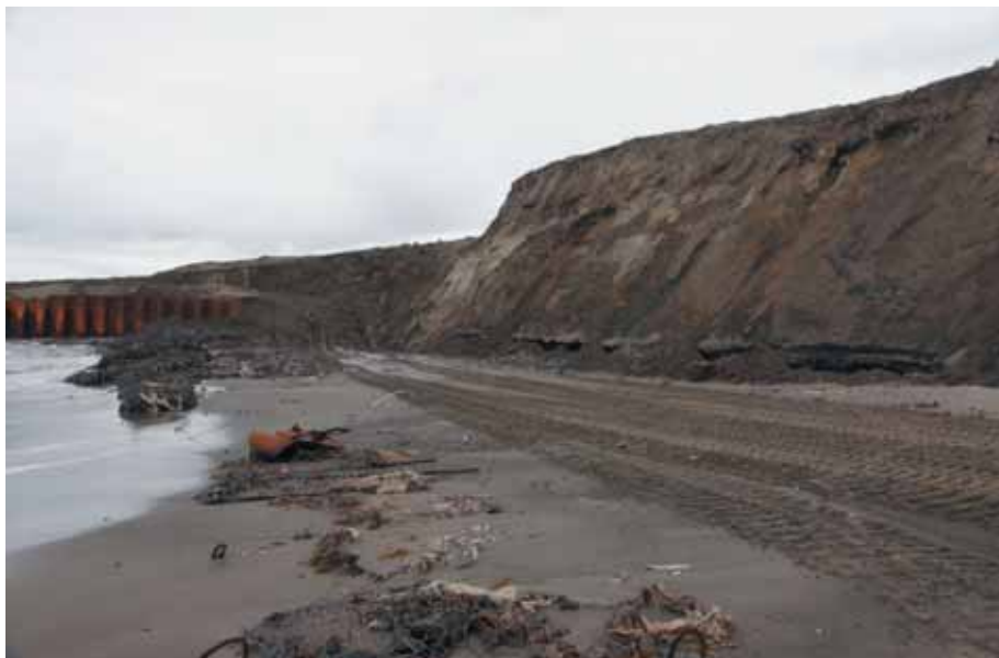
Рис. 2. Термоабразионный берег между строящимися коффердамами на Уральском берегу Байдарацкой губы Карского моря (2011 г.)
